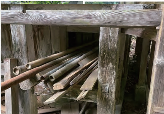
社殿下に無造作に置かれた廃材 (上宮)
