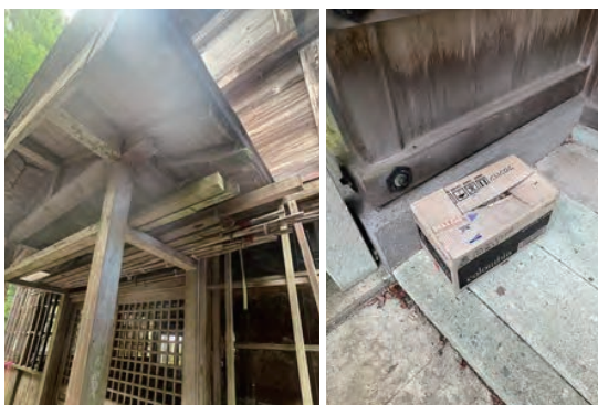
下屋に積み重ねられた木材、放置された箱（下宮）
